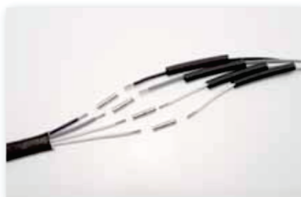
Faça a ligação dos fios utilizando os clips
